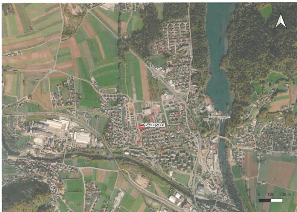
Slika 2: Lokacija AMP Medvode (Vir: Google Earth, 2022).
